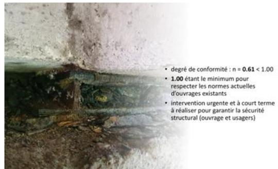
Sur une échelle de 1 à 5 (5 étant le pire), son état est situé à 4, voire 5. À court terme, le pont doit être entièrement assaini. En réalité, le pont n'est pas conforme aux règles. En effet, selon le pourcentage ici projeté, son degré de conformité a été établi à 0.61, le minimum légal étant fixé à 1. Ce qui signifie dans le même temps que si nous voulions maintenir le tonnage actuel à 8 tonnes, il faudrait non seulement assainir le pont comme l'a défini l'étude que nous avons, mais encore le
